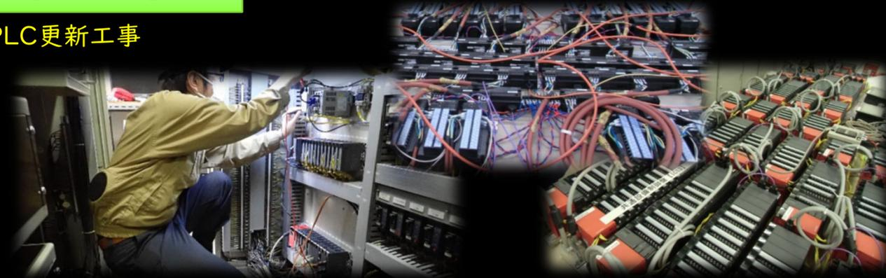
現地にて老朽化したPLCを現行PLCへ更新する工事。ソフトの変換から部品交換作業、調整、稼働確認までを実施いたします。また他メーカーへの更新も承っております。
